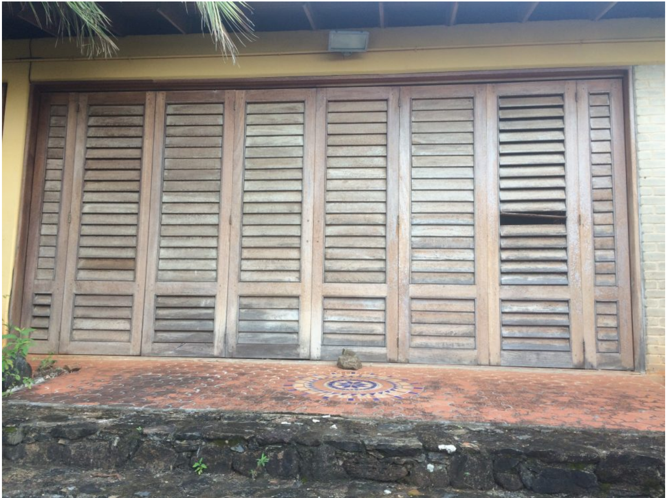
Le porte prima del restauro
