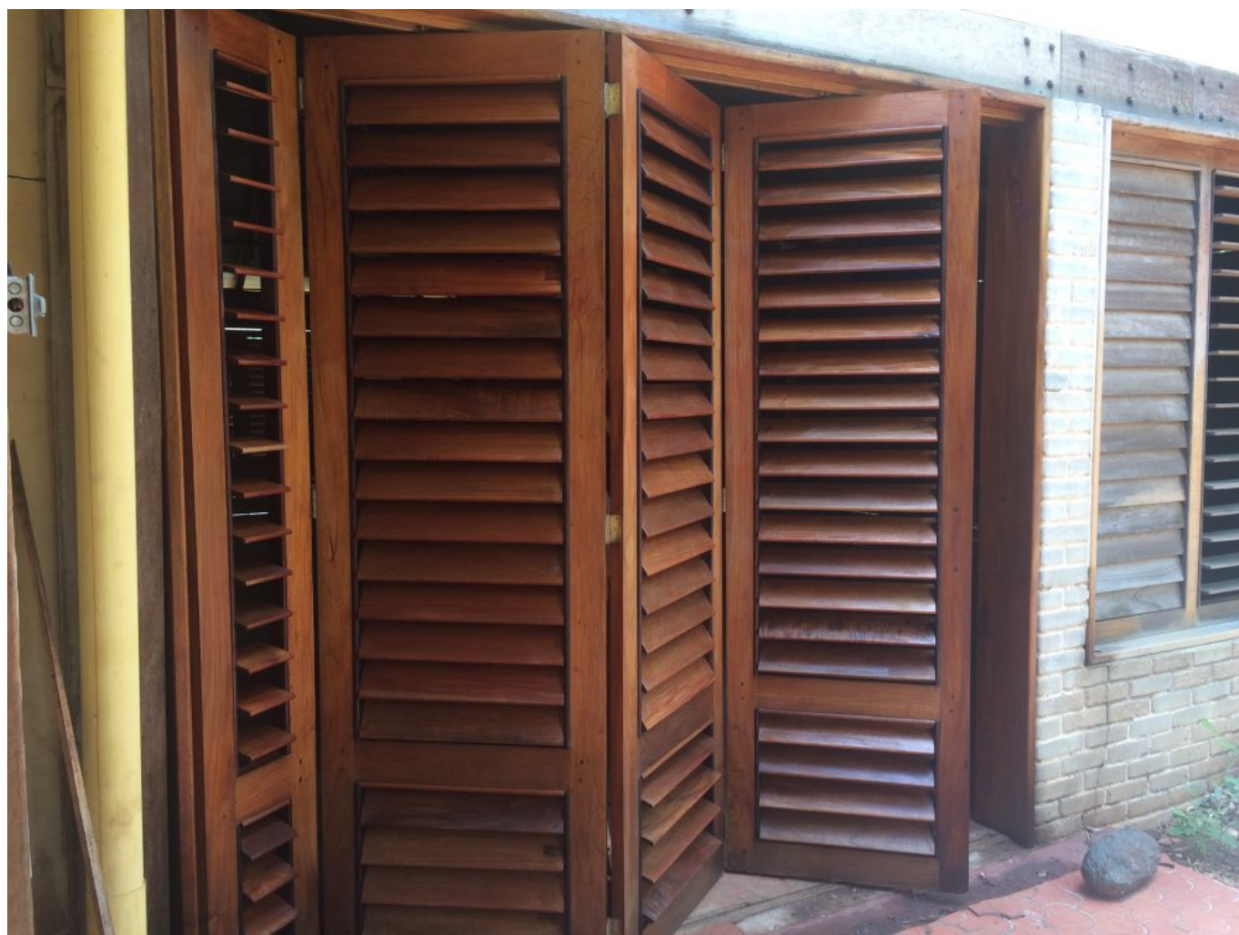
Le porte dopo il restauro
