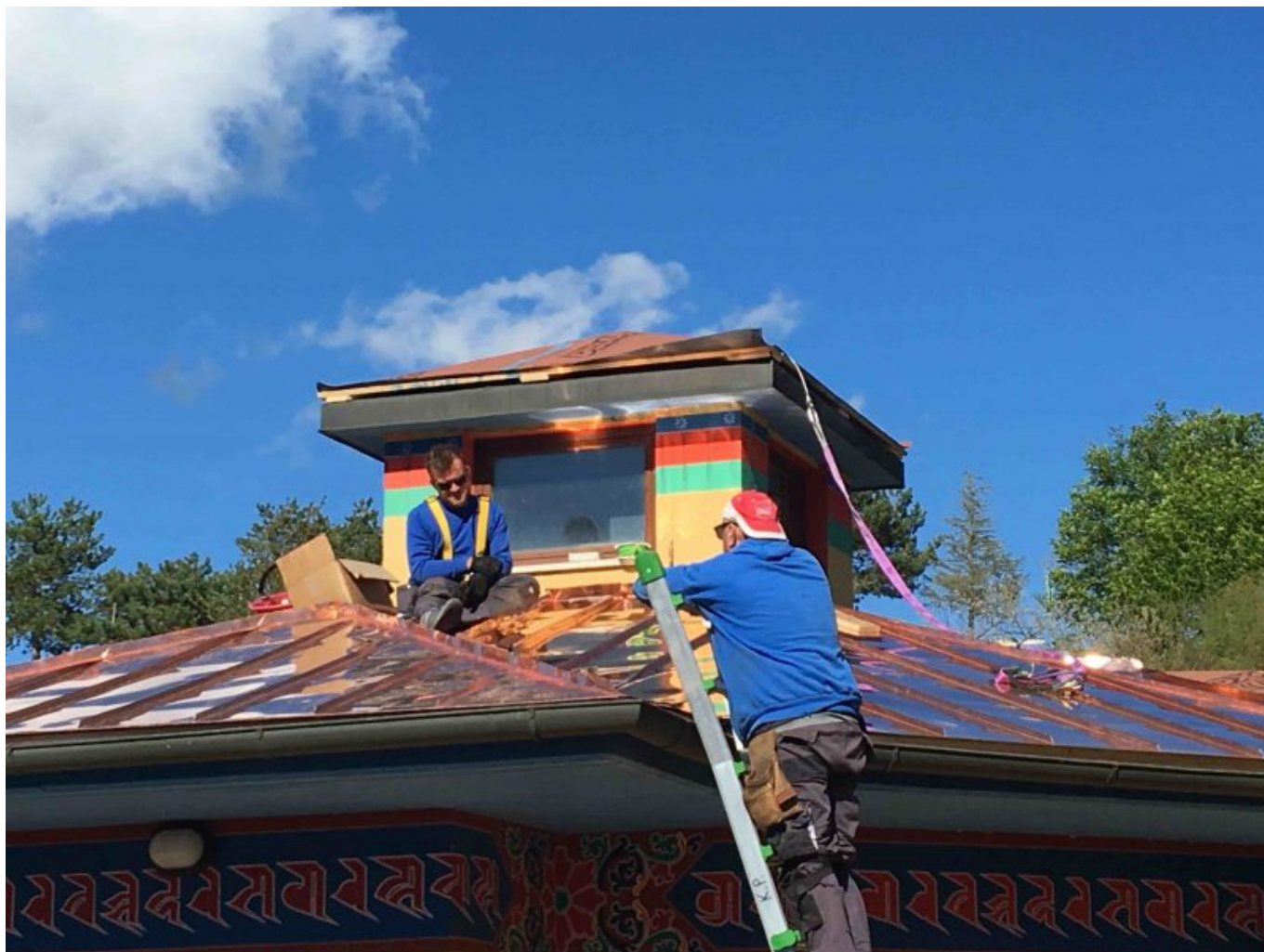
Lavori sul tetto del Cinerario
