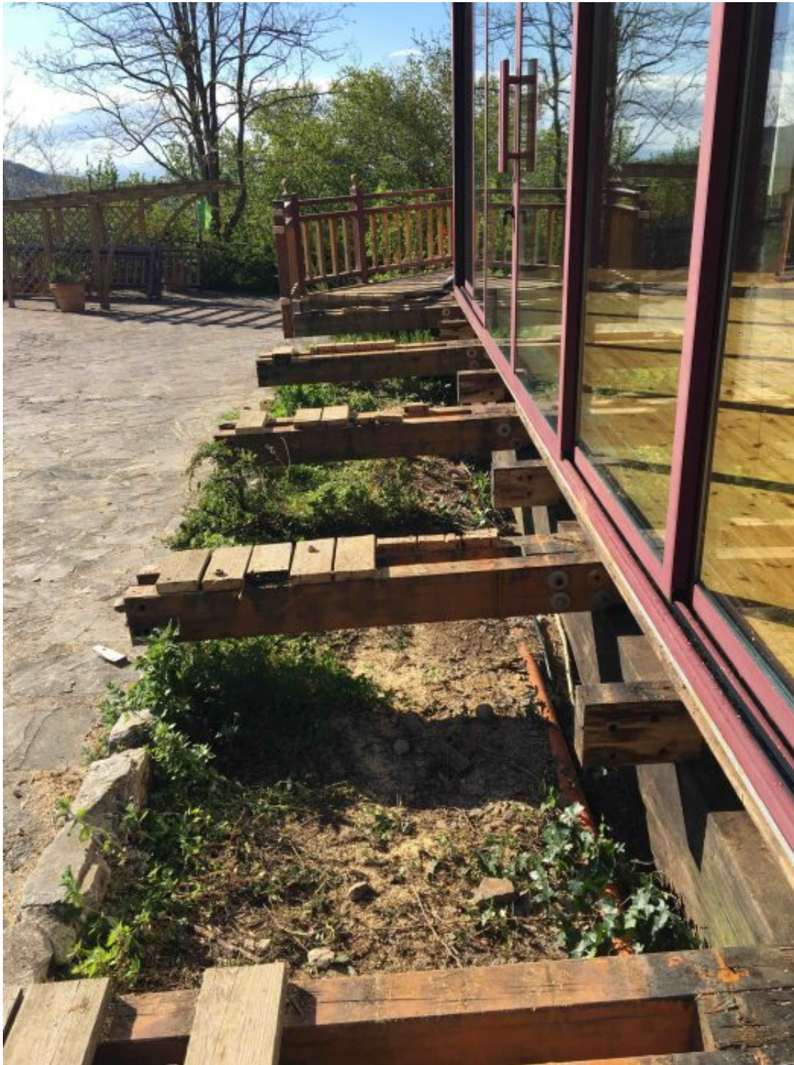
Lavori sul passante esterno del Gönpa
