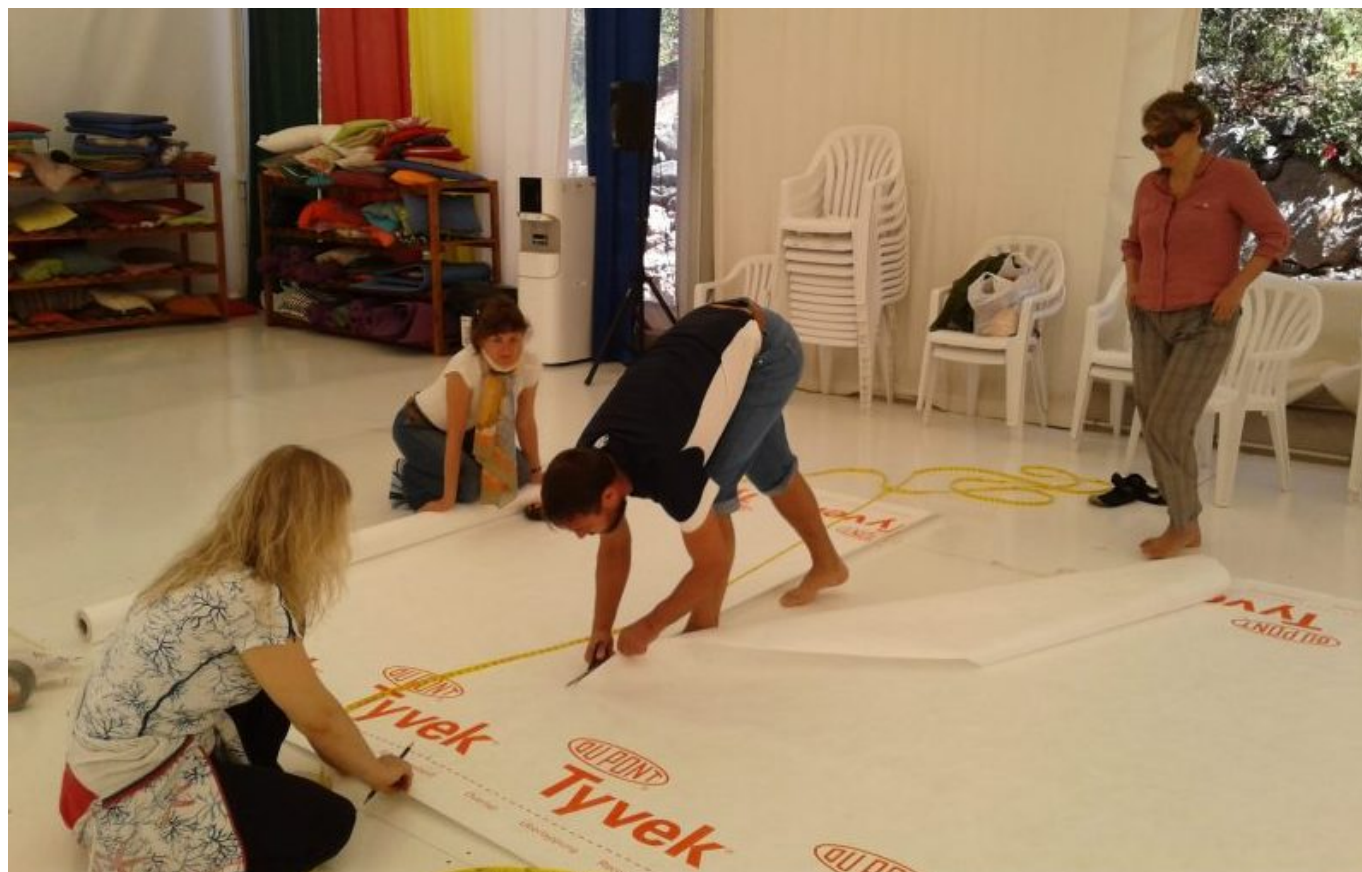
Misurazione e taglio del tyvek
